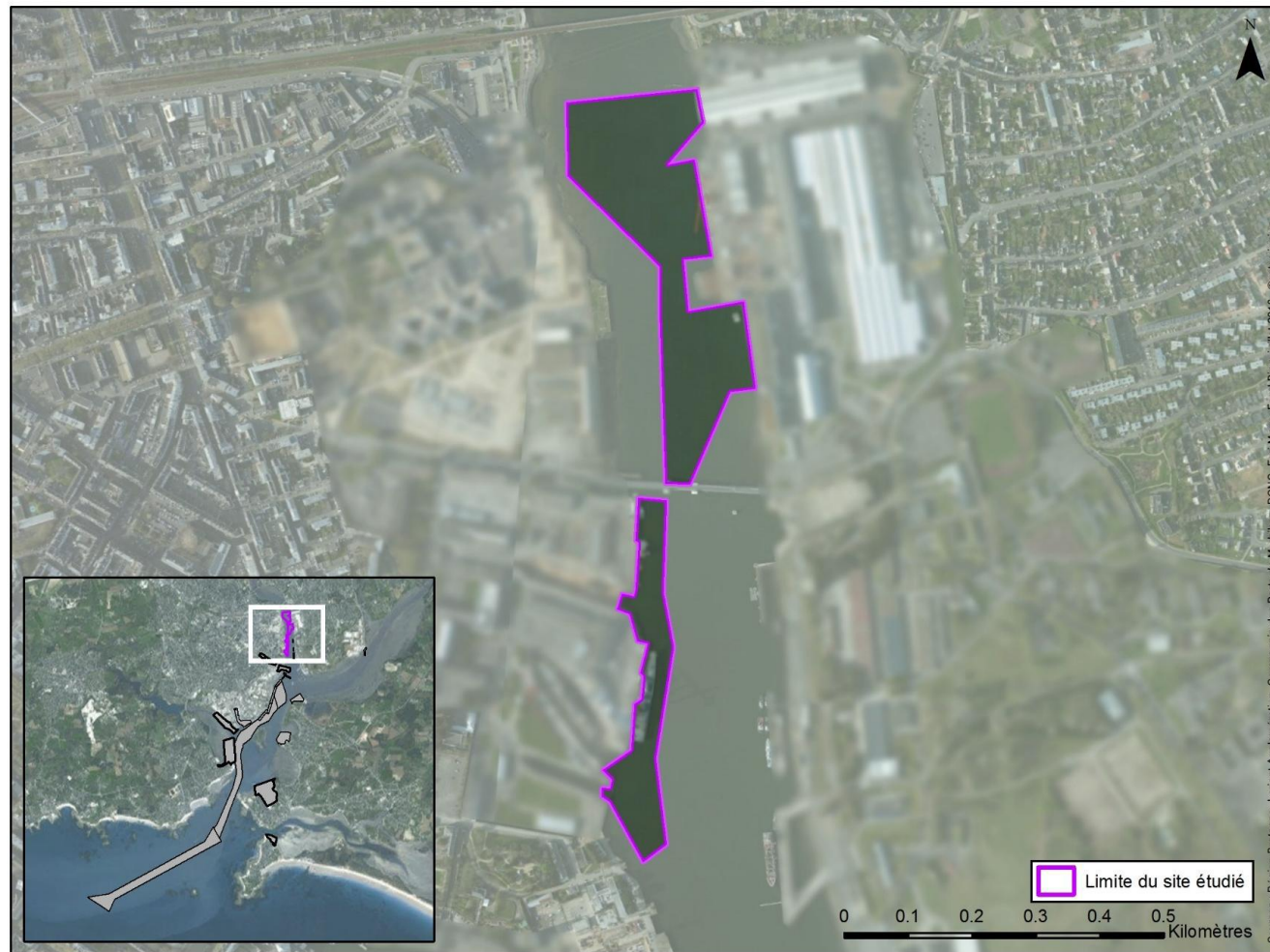
FIGURE 9 – INSTALLATIONS PORTUAIRES NAVAL GROUP SUR LE SCORFF (SOURCE : ANNEXE 2 DU PGOD)
